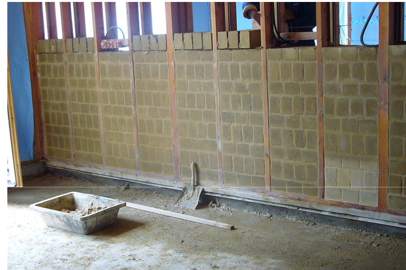
MONTAGE DES MURS EN BTC EN REMPLISSAGE D'OSSATURE
